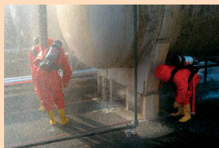
设备检查与堵漏
